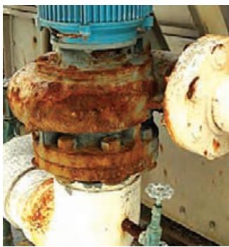
شکل ۵-۵ خوردگی الکتروشیمیایی قطعات فلزی
