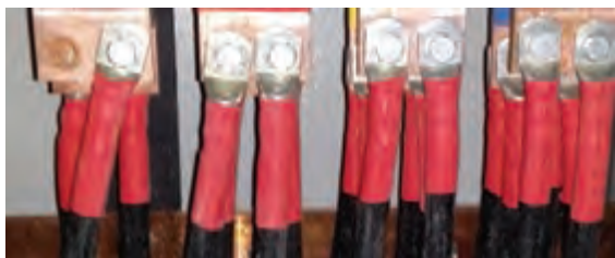
شکل ۱۷- عایق حرارتی کابلشو
