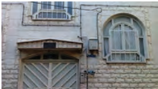
شکل ۱- کابل کشی روی دیوار
