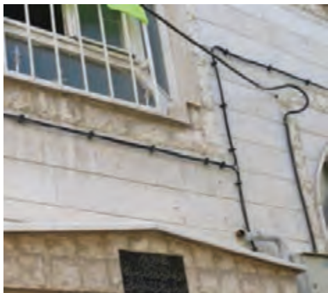
شکل ۲۶ - نصب کابل روی دیوار با بست
