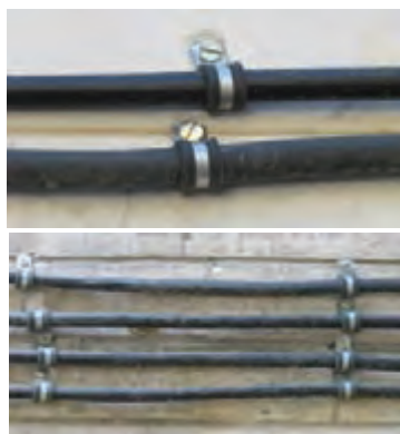
شکل ۲۵- کابل‌کشی روی دیوار
