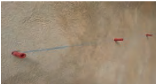
شکل ۳۵- نصب رول پلاک‌ها
