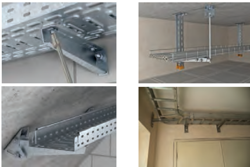
شکل ۶۰- پایه نگهدارنده کشویی، براکت، سایپورت سقفی یا زمینی مدل L، نبشی مشبک یا سایپورت L، ناودانی مشبک، سایپورت قابل تنظیم.
