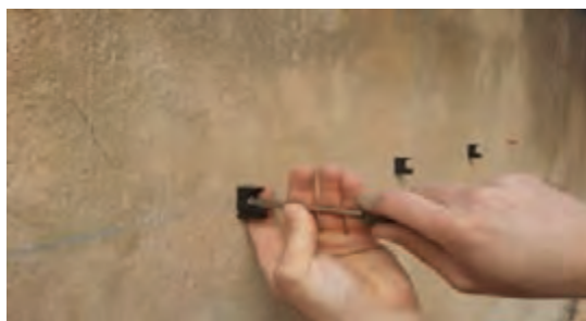
شکل ۳۶- نصب اولیه بست
