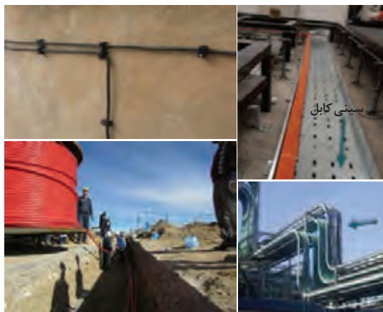
شکل ۱۹- انواع کابل کشی
