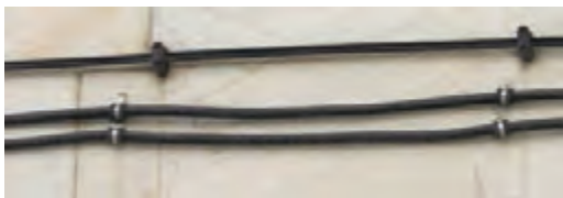
شکل ۲۷ - فاصله بین بست‌ها
