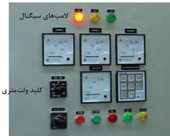
شکل ۷۳- کلید ولت متری و لامپ سیگنال معمولی
