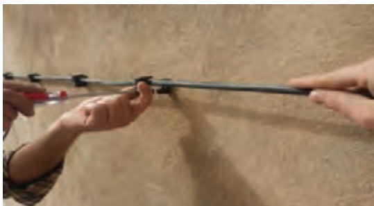
شکل ۳۷- کابل نصب شده روی دیوار
