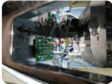
شکل ۶-۵۷ محل اتصال قسمت‌های فلزی
