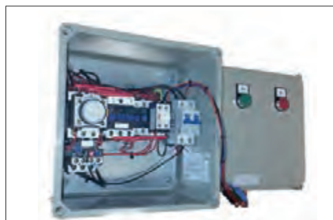
شکل ۲۱- نمونه تابلو جانمایی تایمر پنوماتیکی
