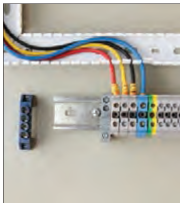
شکل ۵۲- سیم‌کشی روی صفحه نصب
