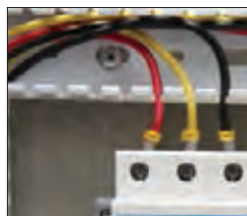
نصب درست شماره سیم
