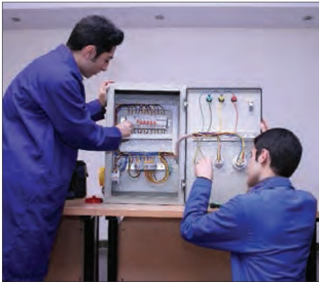
شکل ۲- تابلو برق فشار ضعیف
