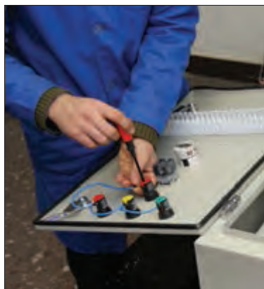
شکل ۹۳- سیم‌کشی چراغ‌های سیگنال
