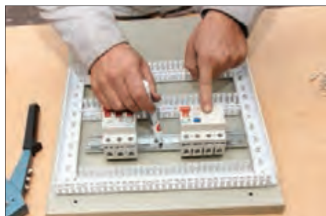
شکل ۴۲- محل نصب ریل فلزی
