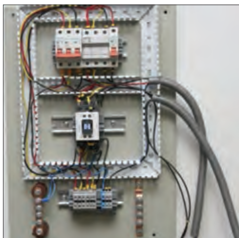
شکل ۹۱- تکمیل سیم کشی قطعات صفحه نصب
