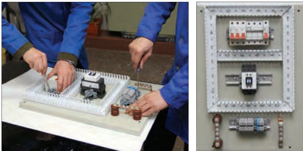
شکل ۸۴ - نصب تجهیزات دیگر
