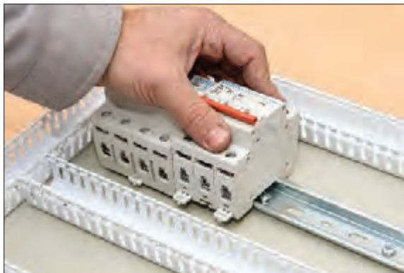
شکل ۴۶- نصب قطعات روی ریل
