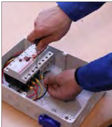
شکل ۲۲- نصب کلید جریان باقیمانده (نشتی)
