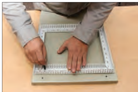
شکل ۴۱- داکت کشی روی صفحه نصب
