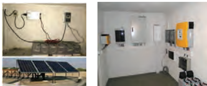
شکل ۴۶- اجرای دو نمونه سیم‌کشی سیستم فتوولتائیک
