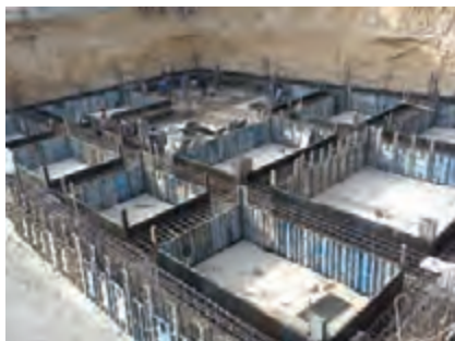
شکل ۵ – قبل از بتن‌ریزی (شالوده)
