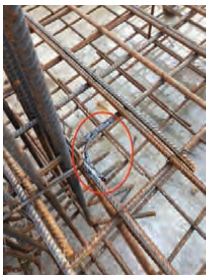
شکل ۲۰- جوشکاری میلگردها در گوشه
