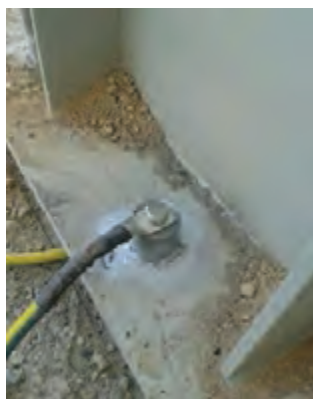
شکل ۲۴- اتصال اسکلت فلزی پیچی
