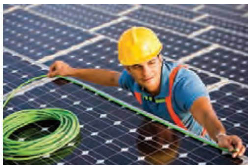
شکل ۳۰- همبندی بدنه فلزی آرایه‌ها و اینورتر
