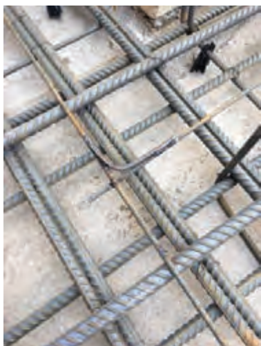
شکل ۲۱- جوش کاری میلگردها در تقاطع سه راهه
