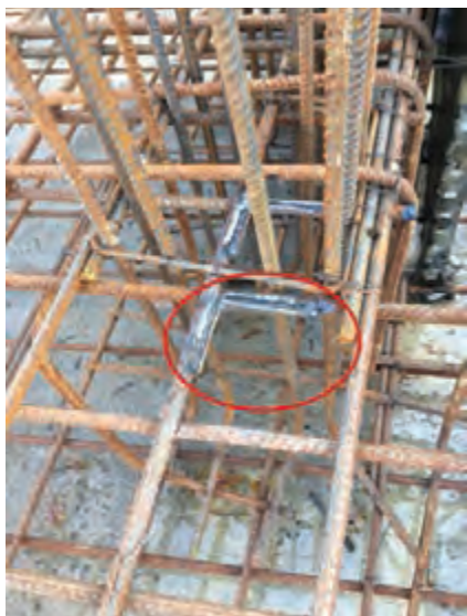
شکل ۱۹- جوشکاری میلگردها در یک تقاطع چهارراه
