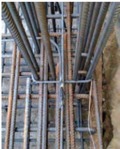
شکل ۲۲- جوشکاری میلگردهای شناژ با شالوده
