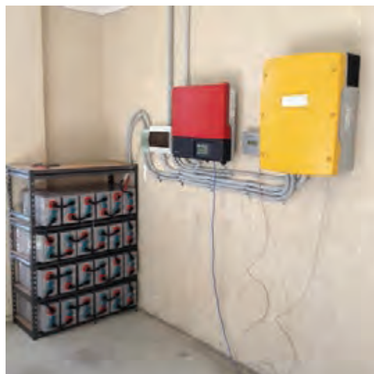
شکل ۶۱- اتصالات سیستم فتوولتائیک
