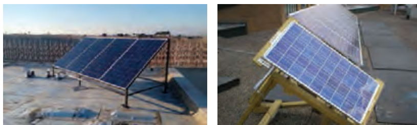
شکل ۵۳ - دو نمونه پایه و سازه پنل خورشیدی (فلزی و چوبی)
