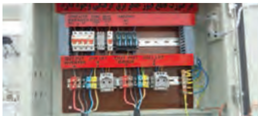
شکل ۶۴- نصب سرچ ارستر
