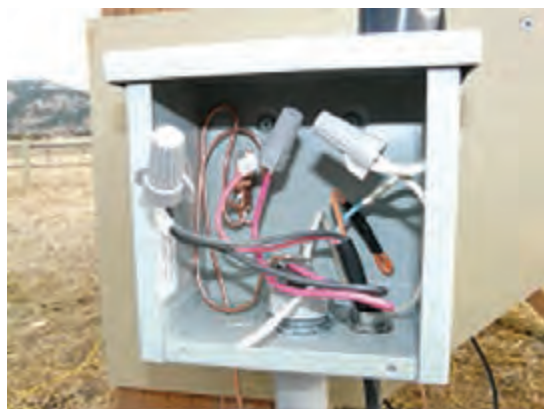
شکل ۳۵- اتصال میله مسی به بدنه تابلو اتصالات
