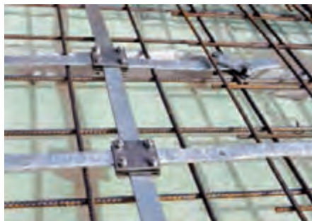
شکل ۹ – تسمه همبندی
