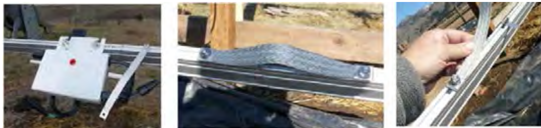
شکل ۲۹- همبندی در سامانه فتوولتاییک
