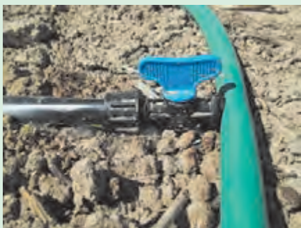
شکل ۱۹-۵. اتصال نوار به لوله و شیر
