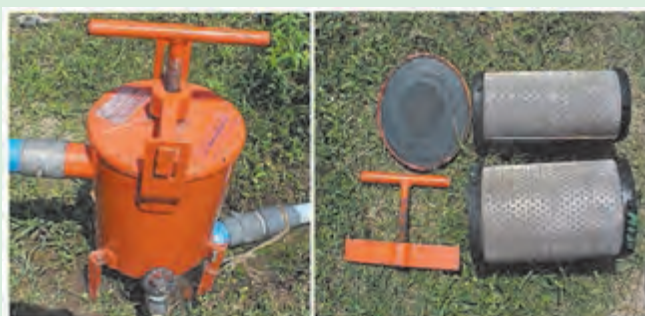
شکل ۵۷-۵. قطعات باز شده صافی توری
