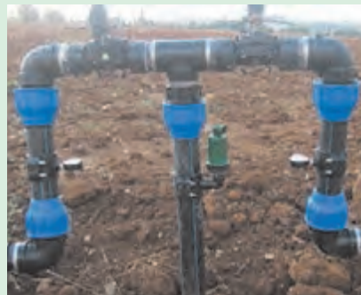
شکل ۳۲-۵. شیر و فشار سنج روی بال ها
