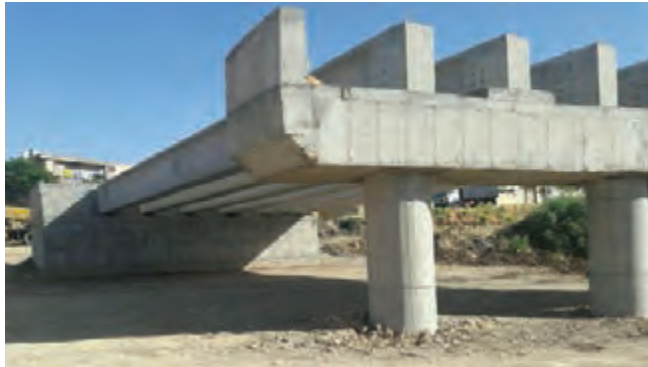
شکل ۱۲- تصویر پل نیمه تمام
