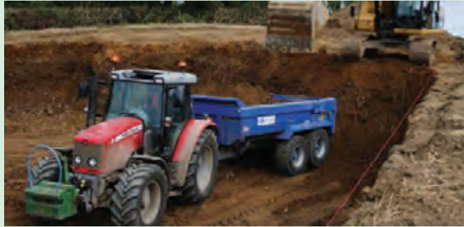
شکل ۱-۵۷- بارگیری نامناسب پی‌نورد
