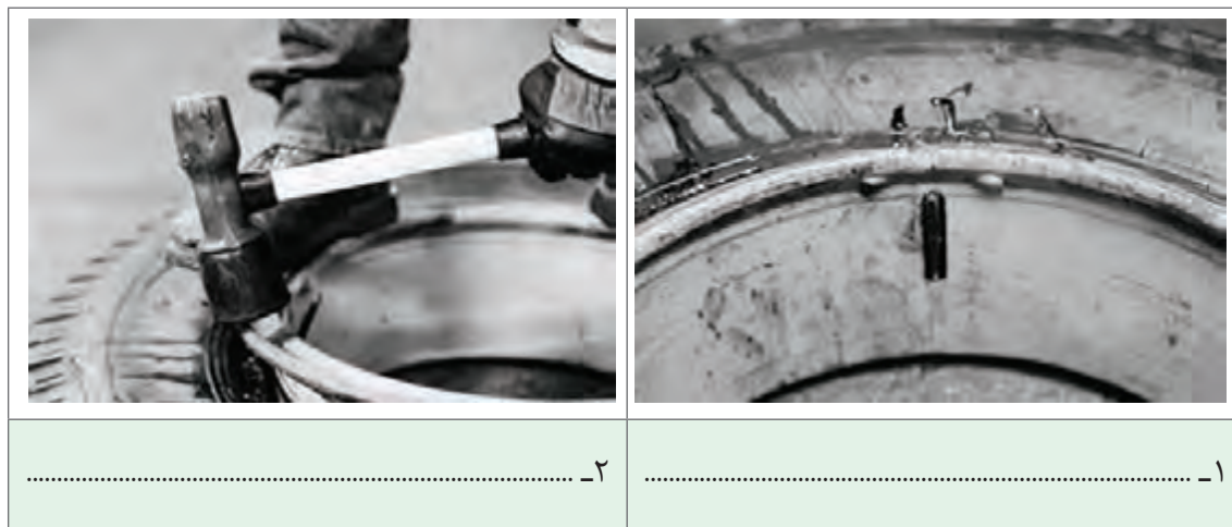
شکل ۷۹-۴ الف - جازدن تایر روی رینگ دو تکه
