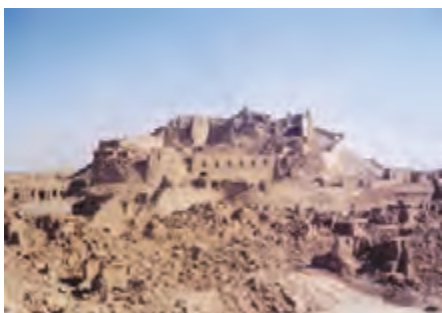
ج) ارگ بم بعد از زلزله
