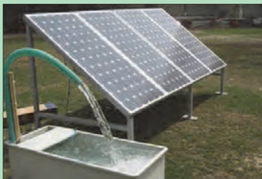
شکل ۳۸- کاربرد سامانه فتوولتاییک در پمپ چاه آب
