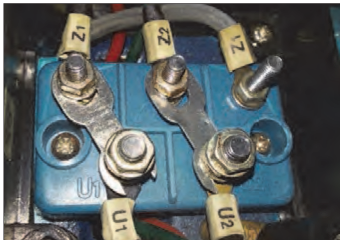
شکل ۵- تخته کلم موتور تک فاز
