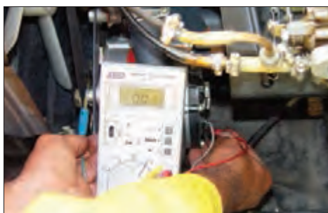
شکل ۳۰- آزمایش اجزای داخلی آلترناتور
