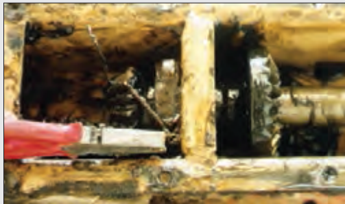
شکل ۲۶- باز کردن سیم مفتولی
