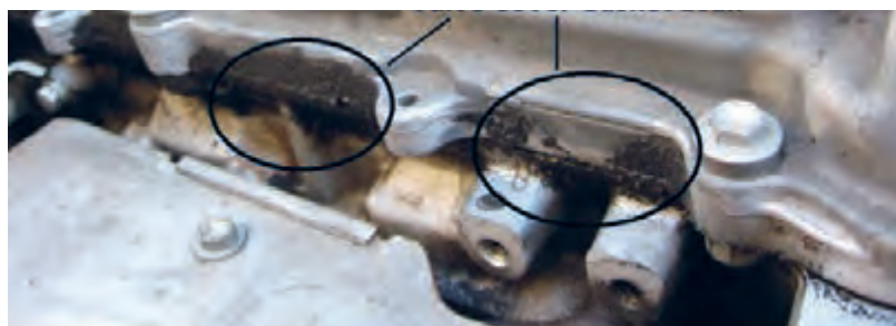
شکل ۲۷. نشتی روغن از درپوش سوپاپ‌ها
