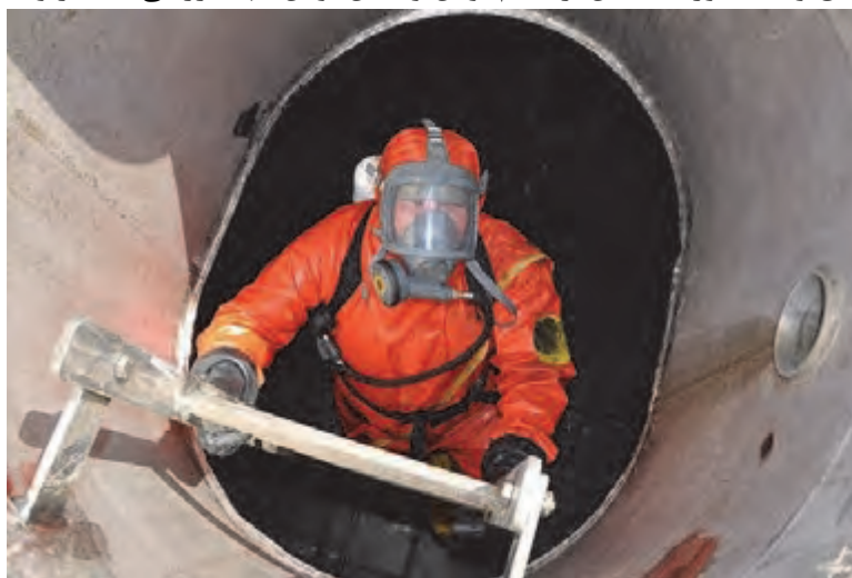
شکل ۱-۳ - تعمیرات دوره‌ای مخازن
