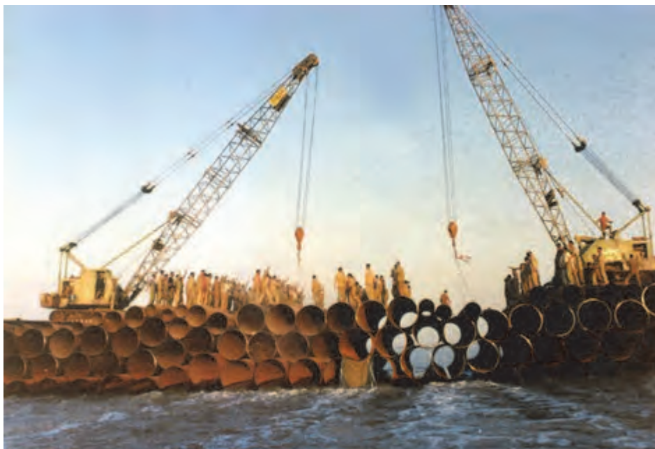
شکل ۱۱-۵- پل بعثت در حال ساخت
