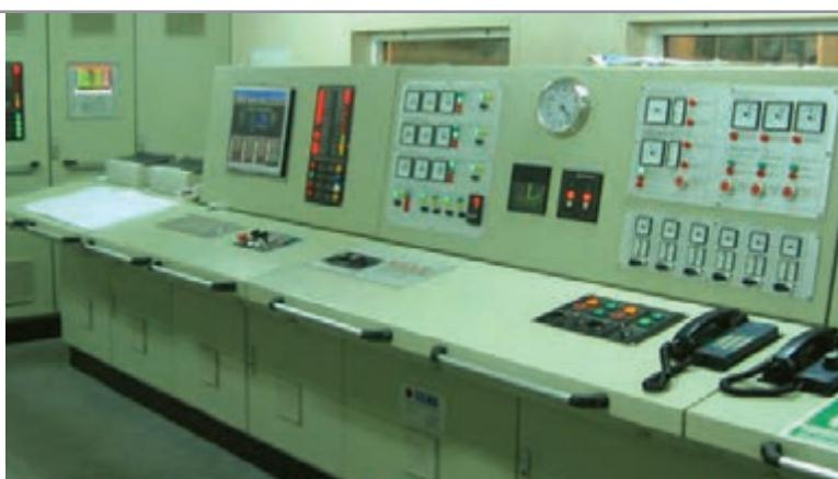
شکل ۴۰ – سامانه هشدار اتاق کنترل موتورخانه
