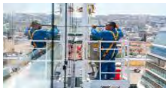
شکل ۱۴-۱ کار کردن در ارتفاع
