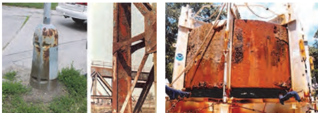
شکل ۵- نمونه‌هایی از خوردگی جوئی
