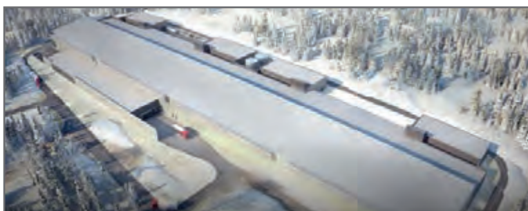
شکل ۸- دیتا سنتر یکی از شبکه‌های مجازی در نزدیکی قطب شمال واقع در سوئد (لولئا)
