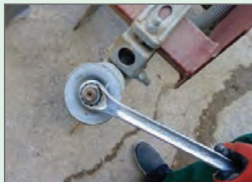
شکل ۴۵- آچارکشی نقاط اتصال اجزا و قطعات
