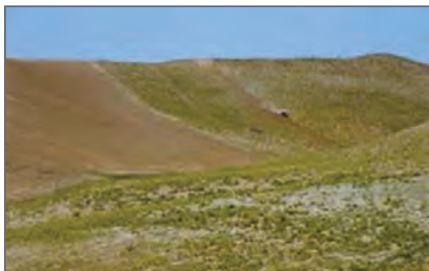
شکل ۷- اجرای شخم در شیب‌های زیاد
