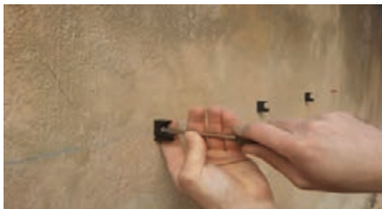
شکل ۳۶- نصب اولیه بست
