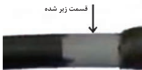
شکل ۷۵- زیر کردن، پاک کردن و تمیز کردن روغن قسمت زیر کابل
