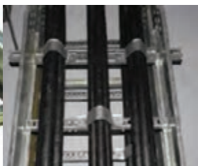
شکل ۵۲- اتصال کابل به نردبان
