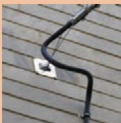
شکل ۵- نصب کابل به دیوار
