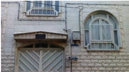
شکل ۱- کابل کشی روی دیوار
