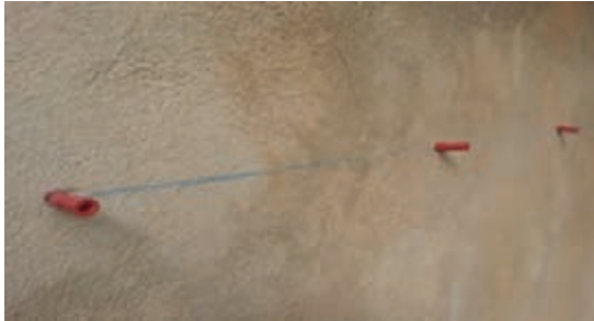
شکل ۳۵- نصب رول پلاک ها
