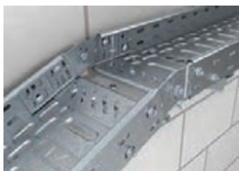
شکل ۴۴- اتصالات سینی کابل
