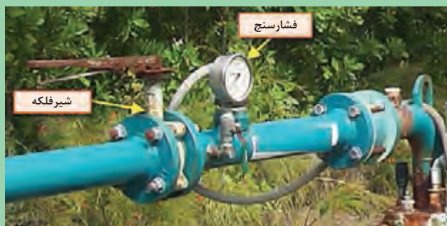
شکل ۱۳- محل شیرفلکه و فشارسنج روی لوله رانش
