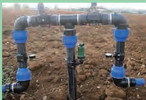
شکل ۱۸- شیر و فشارسنج روی بال ها
