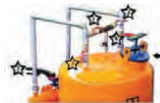
۱ و ۲- شیرهای برگشت (By pass)، ۳ و ۴- شیرهای ورودی و خروجی مخزن ۵- شیر فلکه روی لوله اصلی
