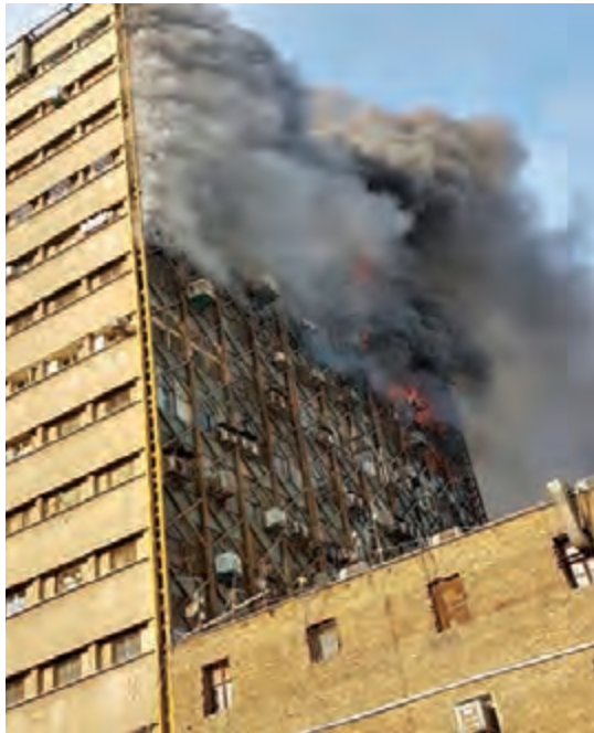
شکل ۹-ب - حادثه آتش سوزی ساختمان پلاسکو
