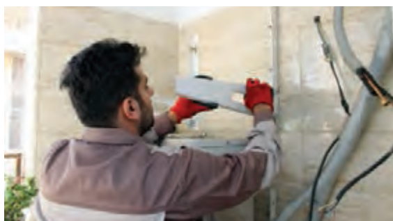
شکل ۷- نصب یونیت خارجی
