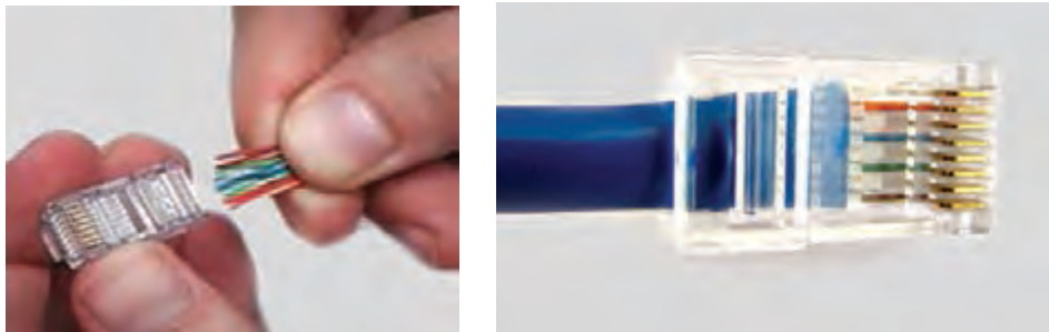
شکل ۲۸- قرار دادن سیم‌ها در سوکت
