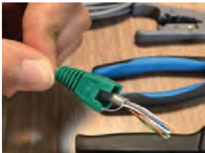
شکل ۲۶- وارد کردن کاور سوکت سر کابل
