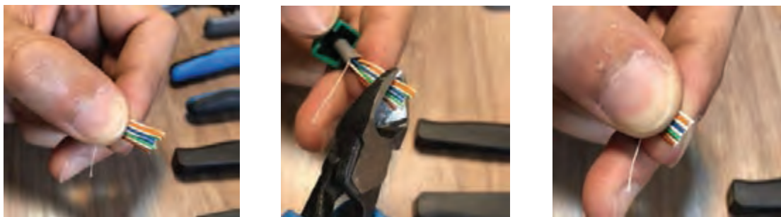
شکل ۲۷- مرتب کردن سیم‌های رنگی مطابق استاندارد
