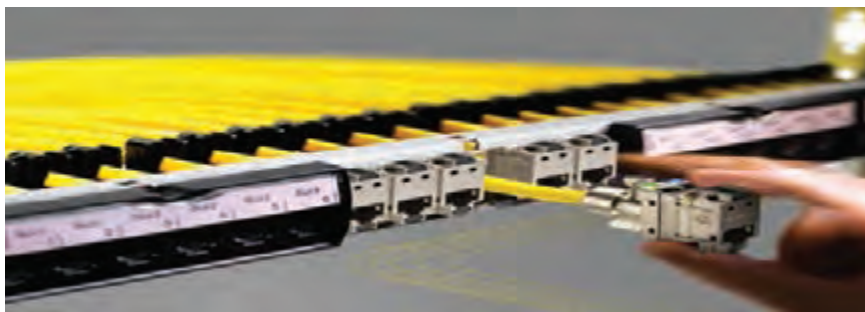
شکل ۵۴ - اتصال کابل به کیستون و قرار دادن در پچ پنل
