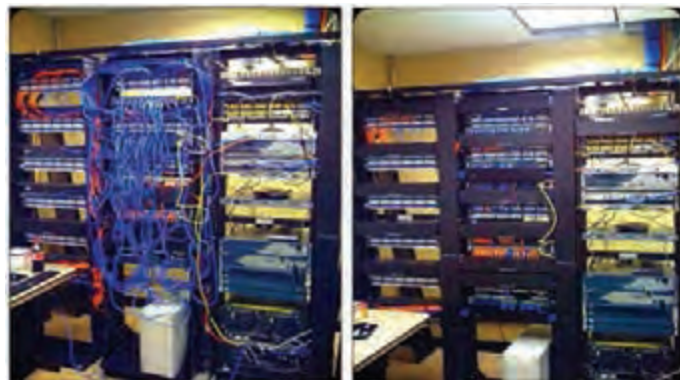
شکل ۴۱- مرتب کردن کابل‌ها
