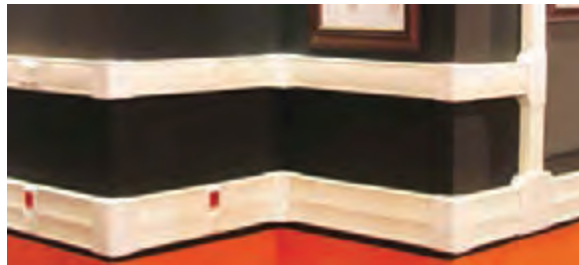
شکل ۵۳ - محل تقاطع ترانک‌ها و داکت‌ها
