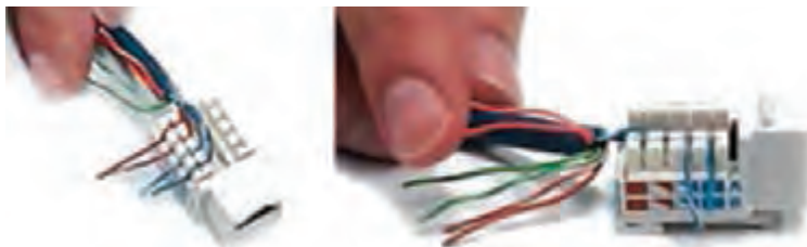
شکل ۳۲- قرار دادن سیم‌های کابل در کیستون
