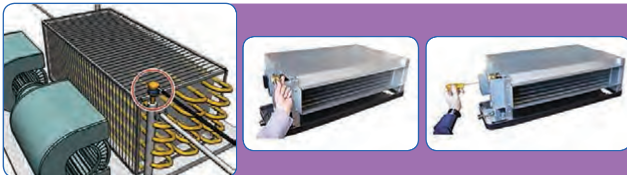
شکل ۲- هواگیری فن کویل
