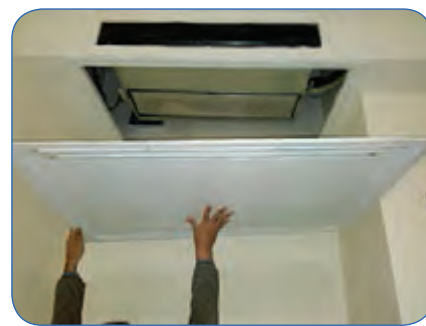
شکل ۱۴- نمونه دریچه دسترسی و برگشت هوا
