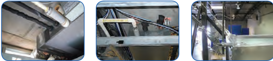
شکل ۸- نمونه اتصال لوله تخلیه به تشتک
