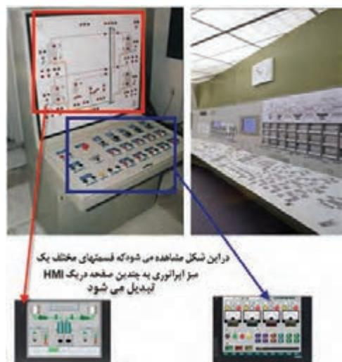
در نهایت، با استفاده از سیستم مانیتورینگ، میزهای اپراتوری با حجم بالا را می‌توان به تابلوی کنترلی مطابق شکل زیر، که دستگاه «HMI» بر روی آن نصب می‌شود، تبدیل نمود.
