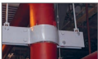
شکل ۱۸- تکیه‌گاه لوله قائم
