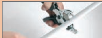
شکل ۵۱ - مراحل اجرای اتصال قفل شونده
