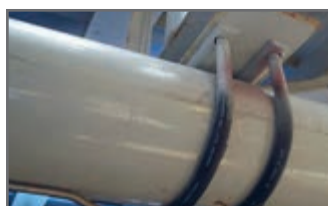
شکل ۱۷- تکیه‌گاه لوله افقی
