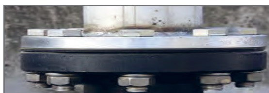
شکل ۲۹- اتصال لوله به فلنج
