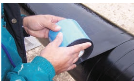
(ب) نحوه پیچیدن نوار
