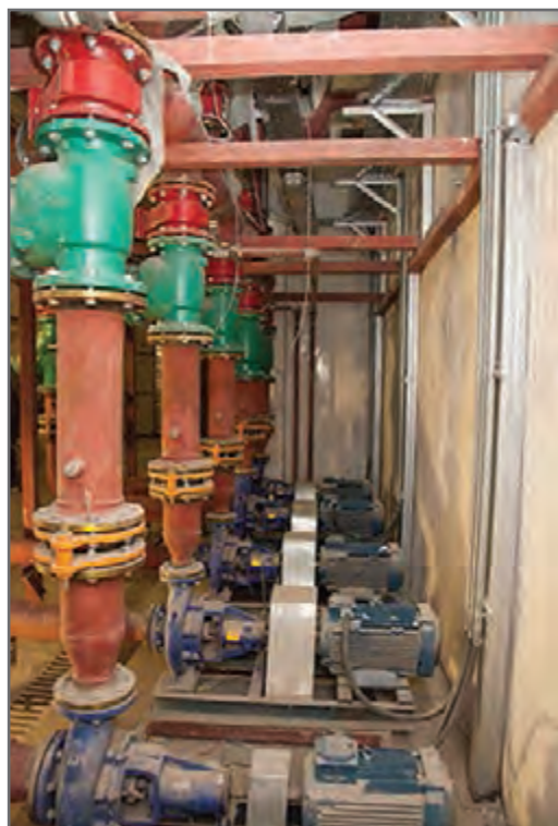
شکل ۳۲ - خط رانش پمپ زمینی
