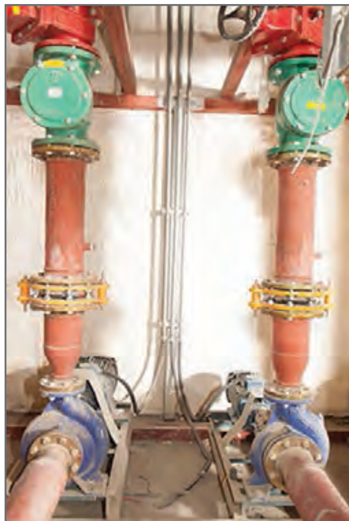
شکل ۳۲ - خط رانش پمپ زمینی
