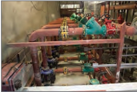
شکل ۳۳- خط مکش پمپ زمینی
