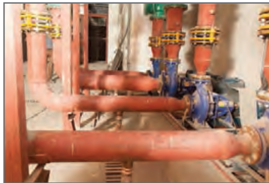
شکل ۳۳- خط مکش پمپ زمینی
