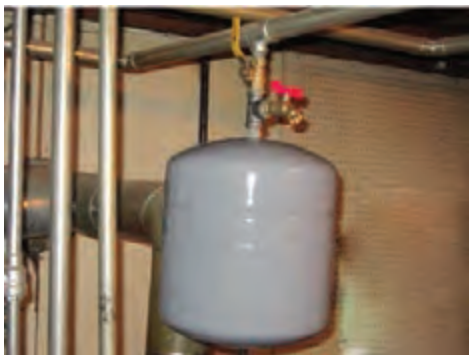
شکل ۲- مخزن انبساط بسته
