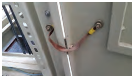
شکل ۱۳- شینه اتصال در
