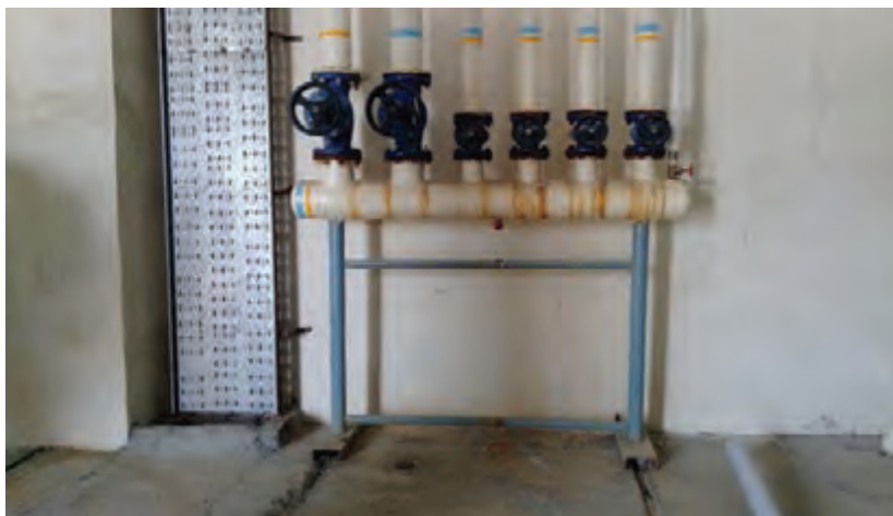
شکل ۲- نصب پایه کلکتور
