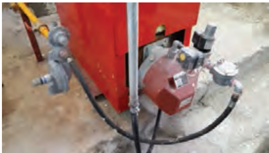
شکل ۲۹- اتصال مدار سوخت
