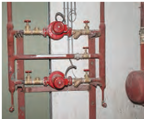
شکل ۲۴- اتصال شیر تخلیه
