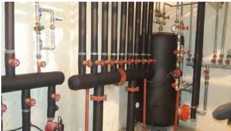
شکل ۲۵- عایق کاری در موتورخانه
