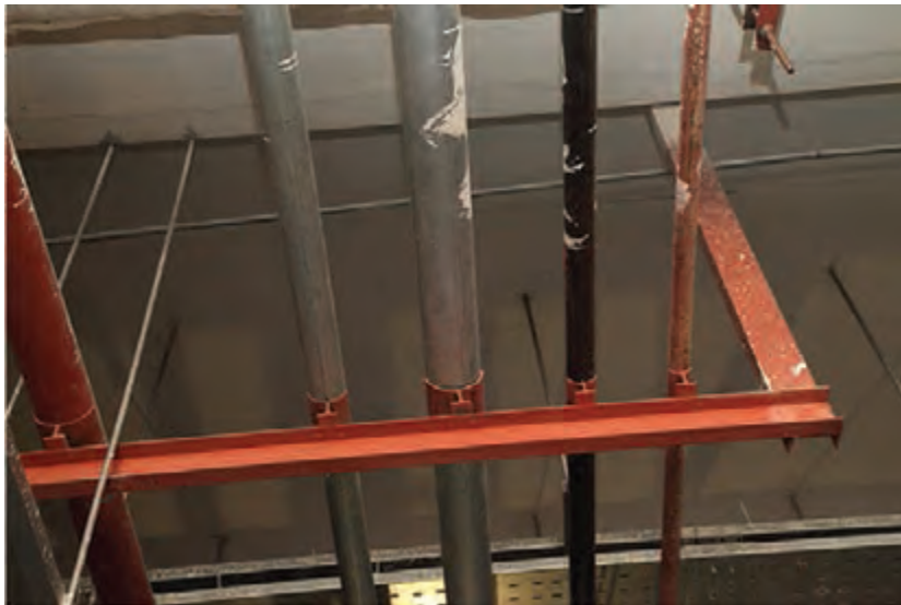
شکل ۱۶- آویز چند لوله‌ای
