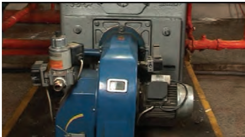
شکل ۲۷- نصب مشعل روی دیگ
