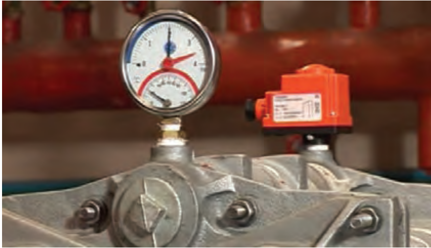
شکل ۲۱- نصب کنترل کننده و نشان دهنده دیگ
