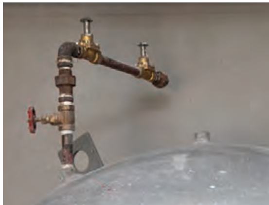
شکل ۲۳- اتصال لوله هواگیری مخزن
