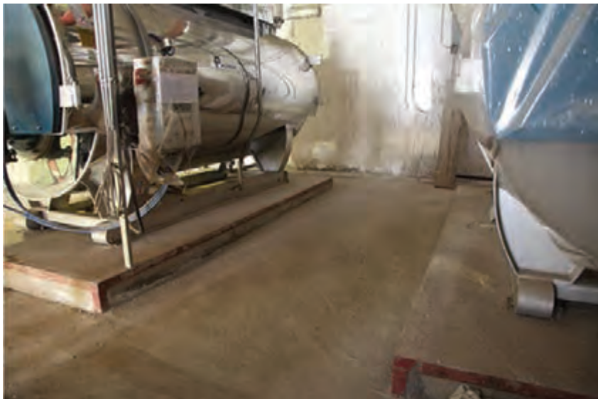
شکل ۱۴ - نصب دیگ روی فونداسیون
