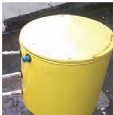
شکل ۳- مخزن انبساط باز با عایق
