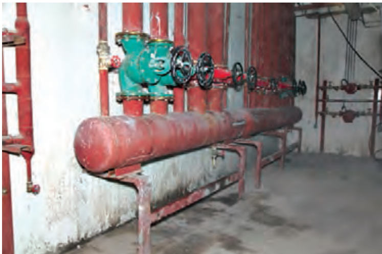
شکل ۱- نصب شیر تخلیه کلکتور
