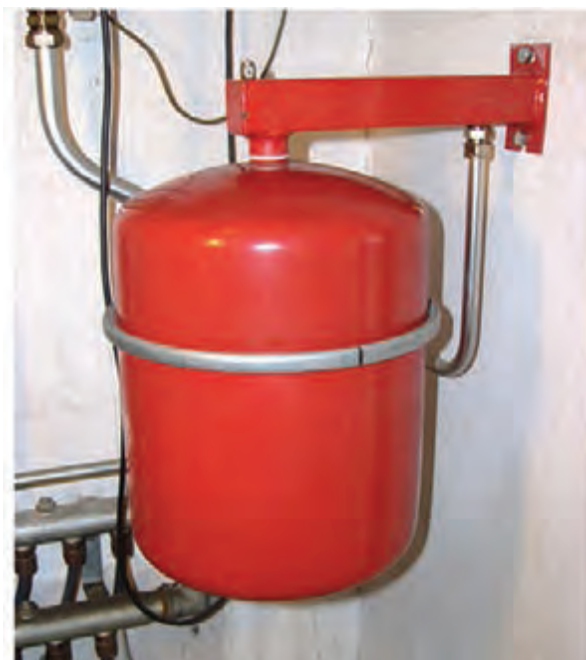
شکل ۱۶- استقرار مخزن انبساط بسته
