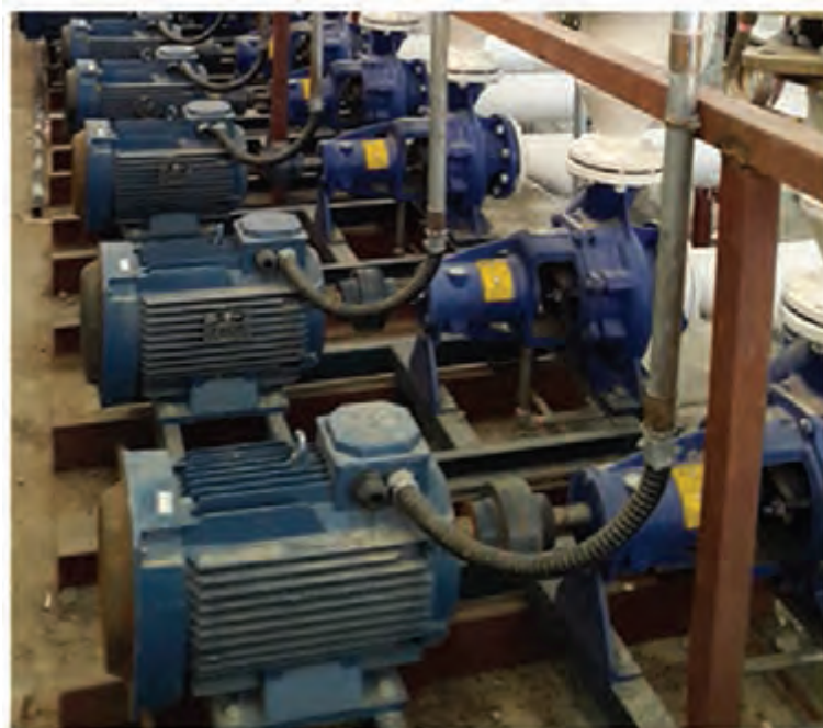
شکل ۲۴- اتصال موتورهای سه فاز
