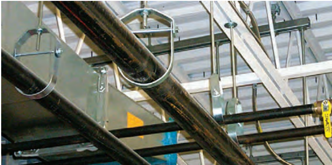
شکل ۱۲- نمونه‌ای از آویز سقفی
