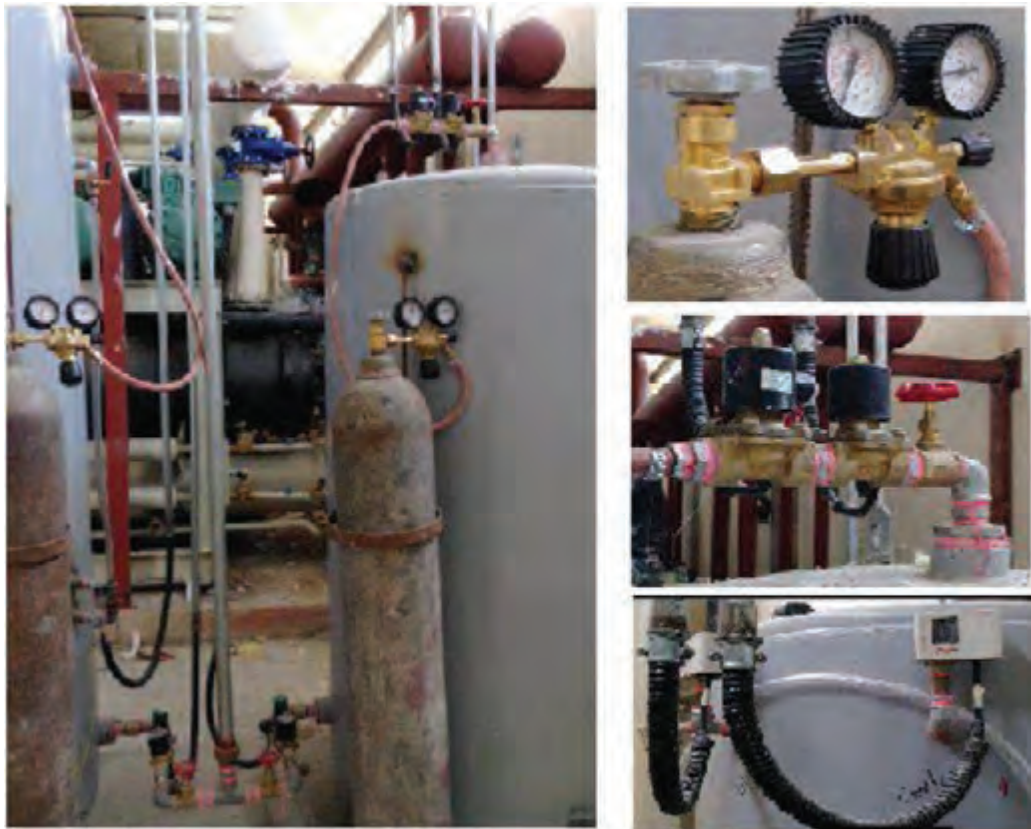
شکل ۲۳- مخزن انبساط بسته با متعلقات
