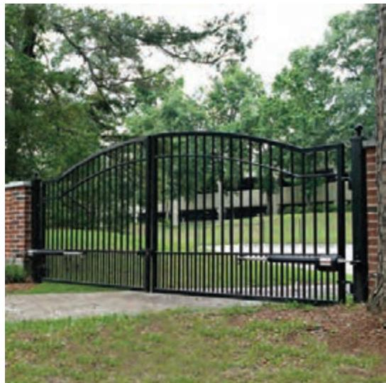
از درب‌های بازویی، که خود شامل درب‌های دولنگه و تک لنگه‌اند عموماً درب ورودی پارکینگ‌های منازل، ساختمان، اనبار، کارخانجات و... جهت کنترل تردد استفاده می‌گردد. این درب‌ها، که عموماً توسط آهنگر و با توجه به نیاز و شکل دلخواه مصرف‌کننده ساخته می‌شود، دارای لولا (جهت کنترل و سهولت باز و بسته شدن)، قفل و متعلقات می‌باشد. تقدم بازشدن با یکی از لنگه‌ها می‌باشد، یعنی یکی از لنگه‌ها حتماً باید اول باز شود و سپس لنگه دوم باز شود.
