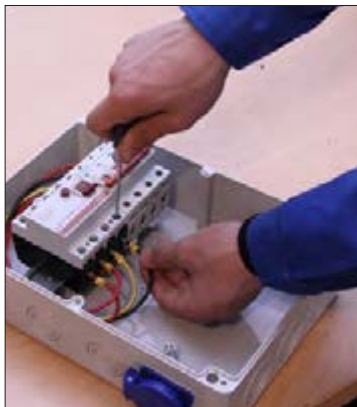
شکل ۲۲- نصب کلید جریان باقیمانده (نشتی)
