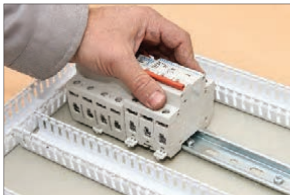
شکل ۴۶- نصب قطعات روی ریل
