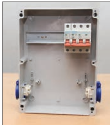
شکل ۲۲- نصب کلید جریان باقیمانده (نشتی)
