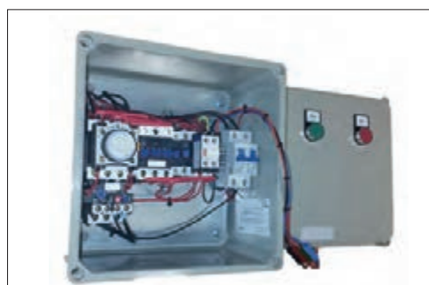
شکل ۲۱- نمونه تابلو جانمایی تایمر پنوماتیکی
