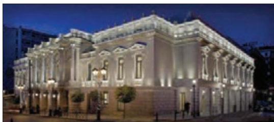
شکل ۱۰۰- روشنایی نمای ساختمان و محوطه
