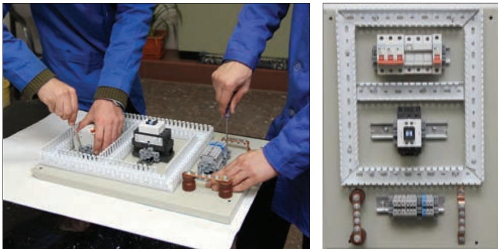
شکل ۸۴ - نصب تجهیزات دیگر
