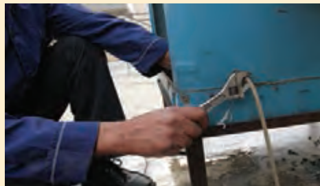
نصب لوله به شیر شناور
