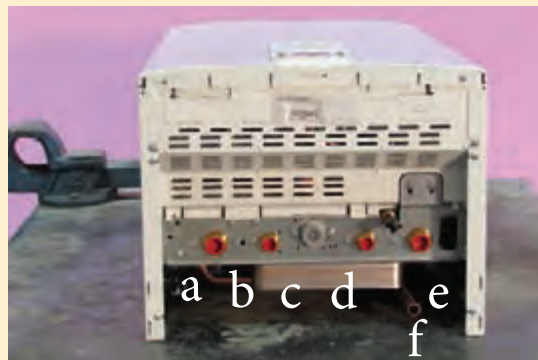
چگونگی اتصال لوله‌های پکیج به سیستم
