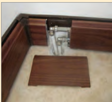
اتصال لوله‌کشی رادیاتور قرنیزی با کاور نهایی
