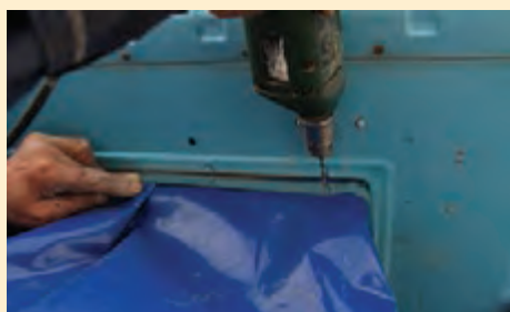
اتصال کانال توزیع هوا به دهانه کولر
