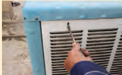
تنظیم آب پخش کن
