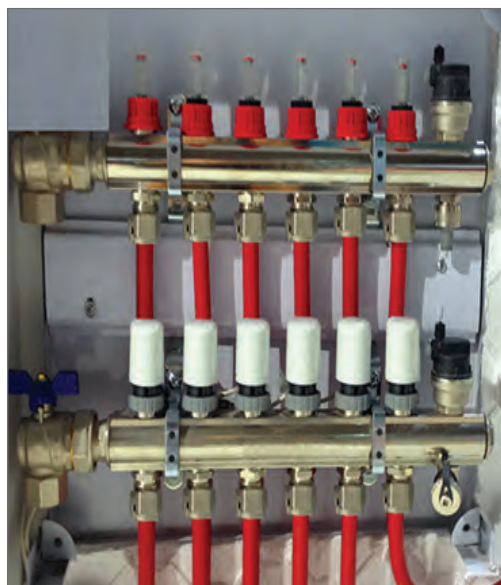
کلکتور سیستم کف گرمایی
