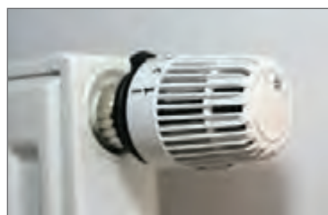
رادیاتور با شیر ترموستاتیکی
