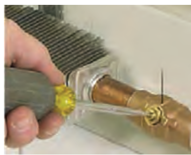
شیر هواگیری کنوکتور
