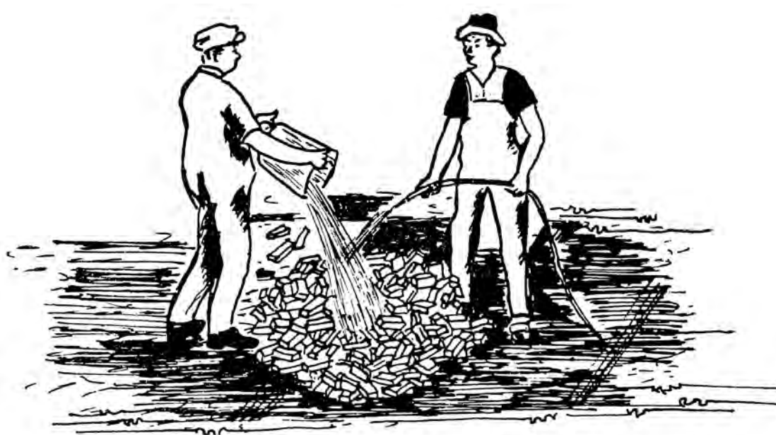
شکل ۳۷ ▲ زنجاب کردن آجر
