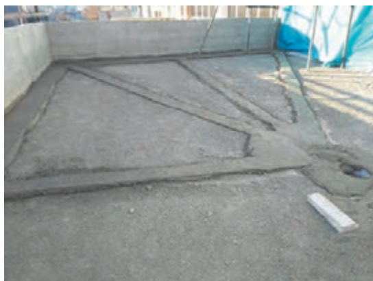
شکل ۱۴ ▲ کرم‌بندی و شمشه‌گیری بین آن‌ها
