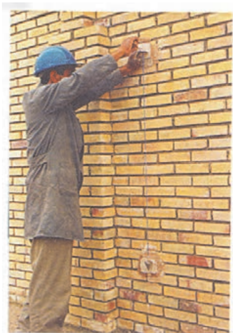
▲ شکل ۲۰ شاقولی کردن کرم‌ها
