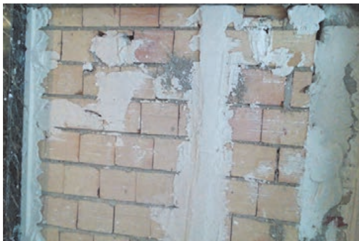
شکل ۲۴ ▲ شمشه‌گیری بین کرم‌ها
