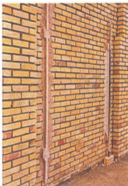
شکل ۲۳ ▲ شمشه‌گیری بین کرم‌ها
