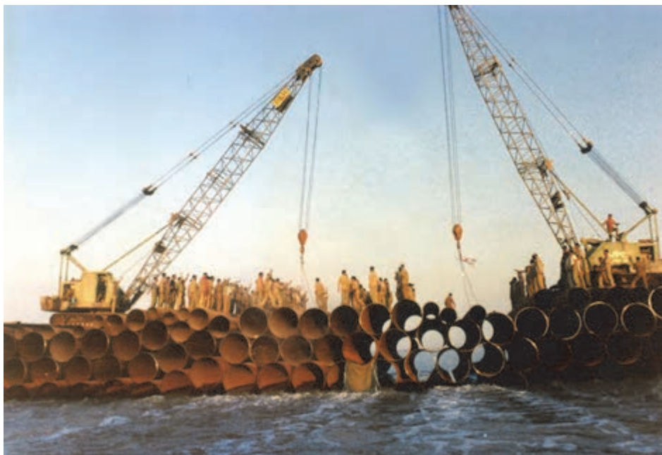
شکل ۱۱-۵- پل بعثت در حال ساخت
