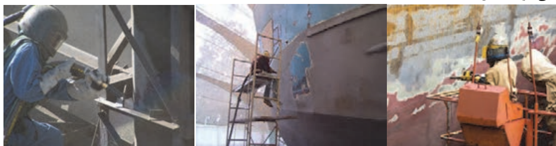
شکل ۱-۷ زنگ‌زدایی در اسکله خشک
