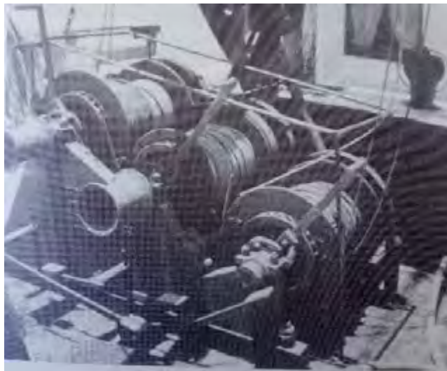
شکل ۵۴- نمونه ای از وینچ مورد استفاده در ترالهای دو بازویی
