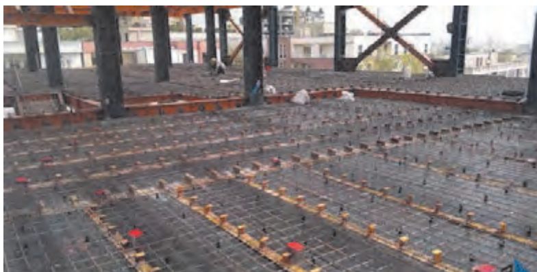
شکل ۳۲ ▲ سقف مرکب به همراه برشگیرها
