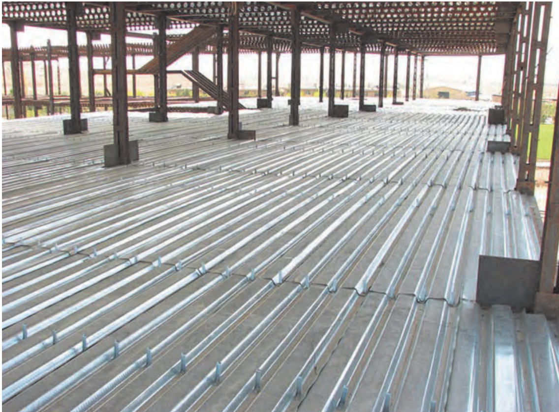
شکل ۳۳ ▲ سقف عرشه فولادی
