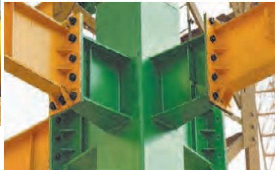
شکل ۵۰ ▲ انواع اتصال فلنجی
