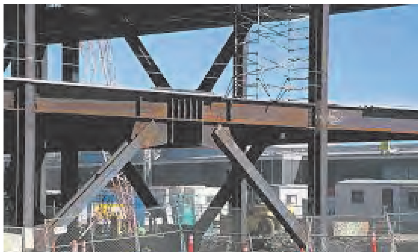
شکل ۲۷ ▲ مهاربند دوزنقه‌ای
