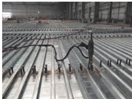
شکل ۳۴ ▲ روش نصب گل‌میخ روی سقف عرشه فولادی
