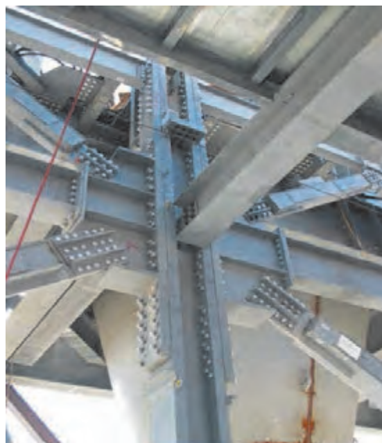
شکل ۵۱ ▲ اتصال مهاربندی
