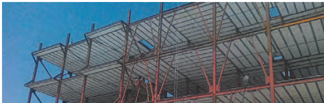
شکل ۲۸ ▲ سقف تیرچه بلوک
