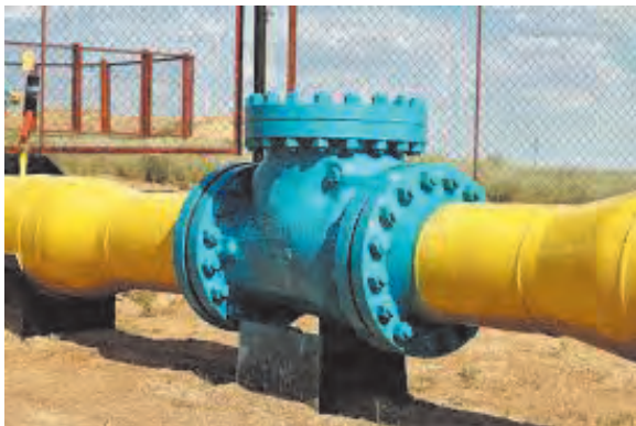
شکل ۵۰ ▲ انواع اتصال فلنجی
