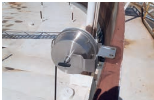
شکل ۴-۲۶- تخلیه الکتریسیته ساکن در مخزن سقف شناور
