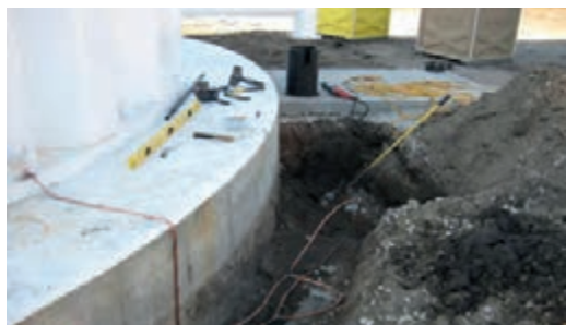
شکل ۴-۲۵- تخلیه الکتریسیته ساکن بدنه مخزن به زمین
