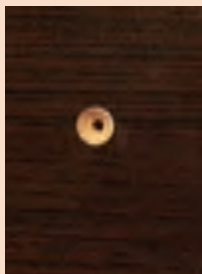
شکل ۱-۱۳۳-الف - عمق خزینه صحیح
