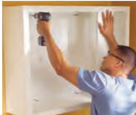
شکل ۲۳-۵ - پیچ و رولپلاگ
