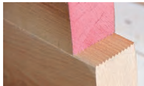
شکل ۱۳- اتصال انگشتی ساخته شده با دستگاه فرز
