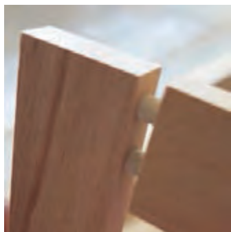
شکل ۱۱- اتصال دوبل (میخ چوبی)
