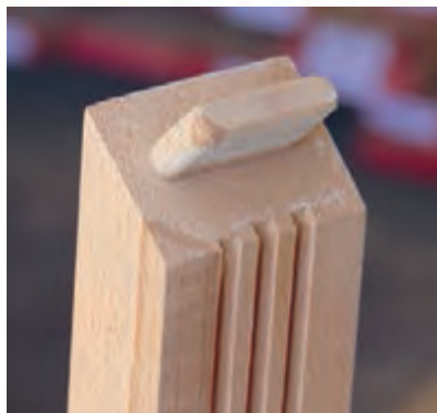
شکل ۵۹- اتصال کام تحت زاویه ۴۵ درجه
