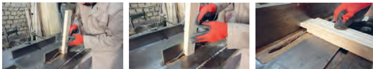
شکل ۹۱- عملیات برش زبانه با دستگاه اره گرد
