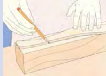
شکل ۴۵- انتقال الگوی پایه میز عسلی از روی شابلون به روی چوب
