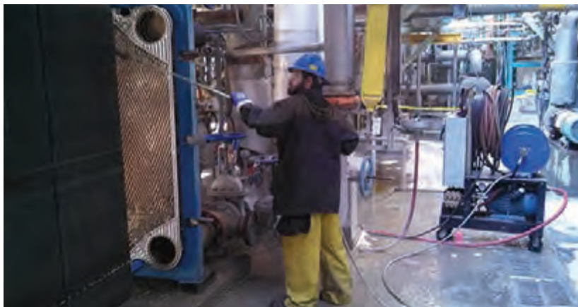
شکل ۱۵- روش فشار آب (جت آب)
