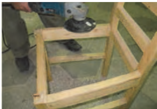
شکل ۷۲- پرداخت کاری قبل از بتونه
