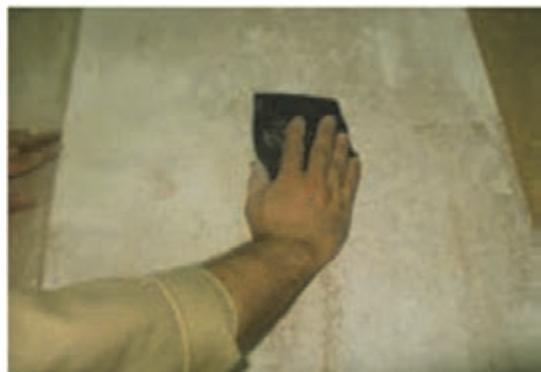
شکل ۸۰- سنباده کاری روی سطح بتنه سریشی
