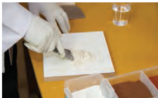
شکل ۶۷- بتونه‌کاری پوششی
