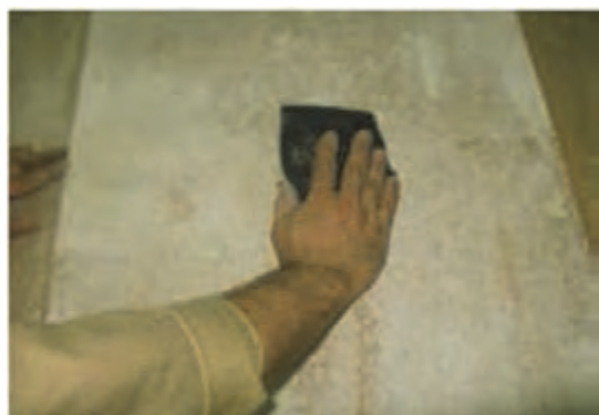
شکل ۸۰- سنباده کاری روی سطح بتونه سریشی
