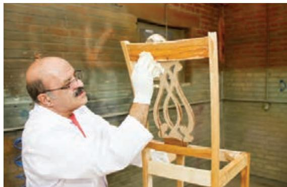
شکل ۱۴۶- زدن سیلر با کهنه رنگ کاری
