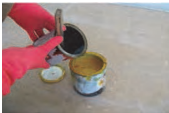
شکل ۸۵- اضافه کردن روغن جلا به رنگ روغنی
