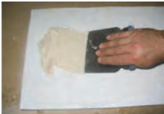
شکل ۹۱- ساخت بتونه سریشی
