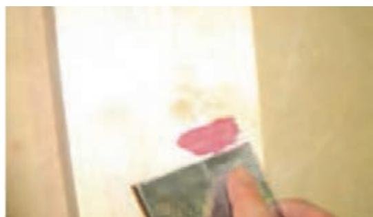
شکل ۹۳- لکه‌گیری قبل از ماستیک کاری
