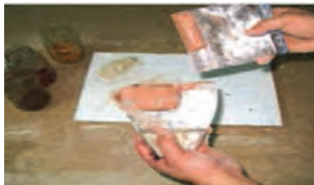
شکل ۴۶- ساخت بتونه هم‌رنگی
