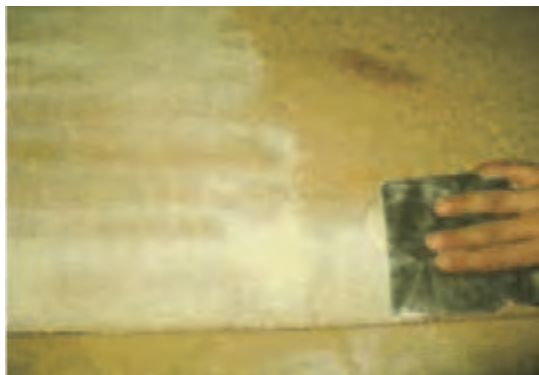
شکل ۷۳- استفاده از بتونه رقیق
