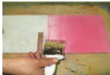
شکل ۶۹- زدن رنگ روغنی، به کمک قلم مو
