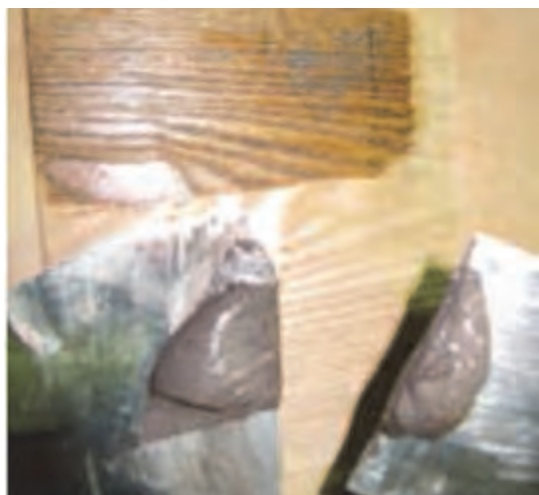
شکل ۱۳۸- برداشتن بتونه
