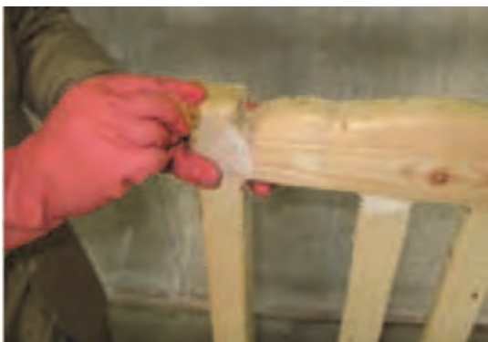
شکل ۷۱- بتونه کاری غیر پوششی
