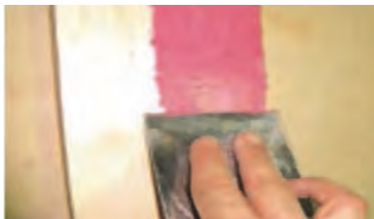
شکل ۹۲- ماستیک کاری با بتونه روغن رنگ قرمز
