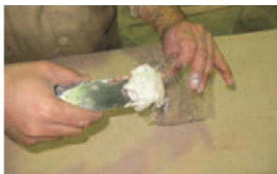
شکل ۶۸- قرار دادن بتنه سریش داخل پلاستیک
