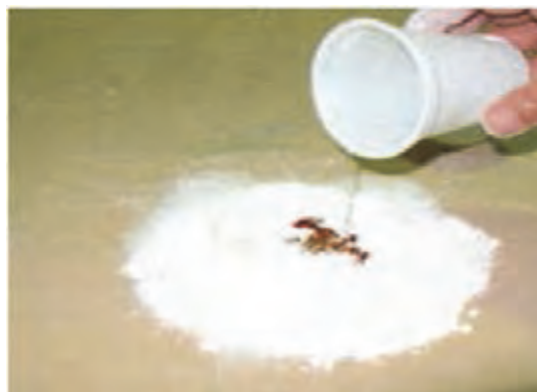
شکل ۷۸- اضافه نمودن آب به بتونه روغنی
