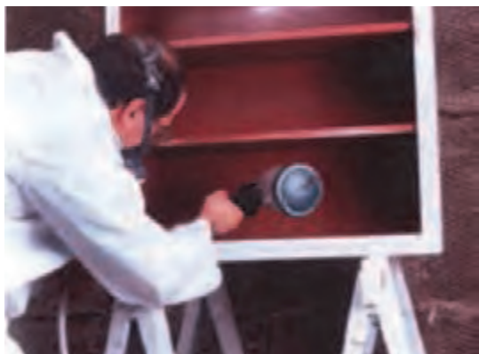
شکل ۲۳- رنگ کاری قسمت های داخلی
