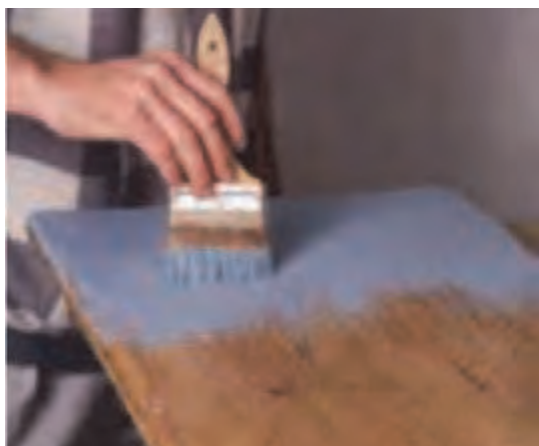
شکل ۲۱- زدن آستری یا قلم‌مو
