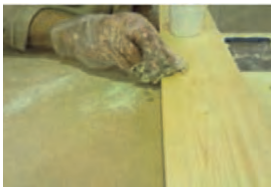
شکل ۶۶- زدن آب قبل از بتونه‌کاری
