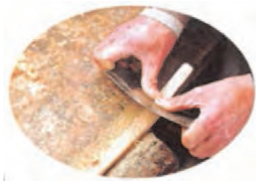
شکل ۵۶- استفاده صحیح از لیسسه
