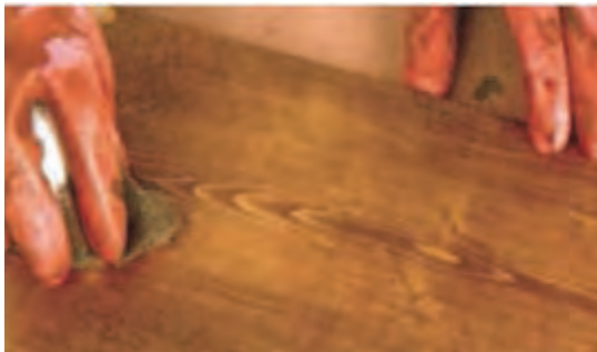
شکل ۱۴۴- زدن آستری هم رنگی با پارچه
