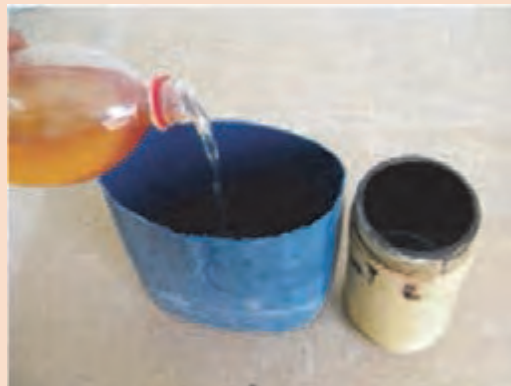
شکل ۷- رقیق کردن آستری قیری با بنزین
