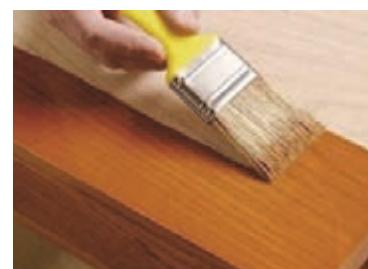
شکل ۵۷-روغن اندود کردن سطح کار
