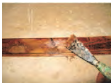
شکل ۵۴- آب زدن به بتونه هم‌رنگی شکل ۵۵- یک تخته آستری خورده شکل ۵۶- استفاده از بتونه رقیق در مرحله اول
