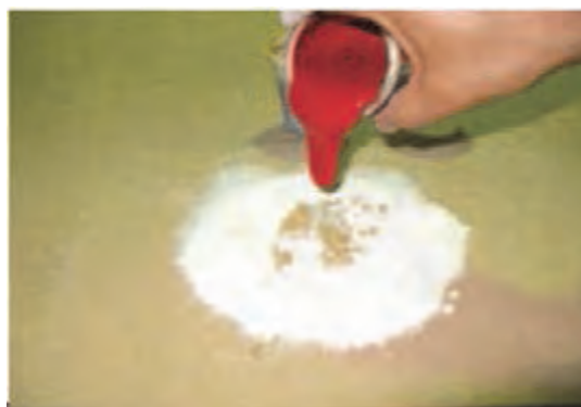
شکل ۷۹- اضافه نمودن روغن الیف به بتونه روغنی
