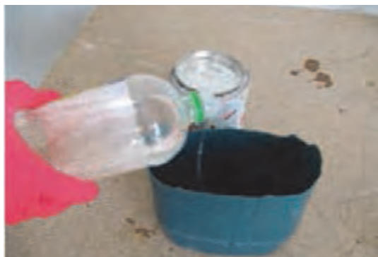
شکل ۸۴- استفاده از تینر فوری در روغن جلا
