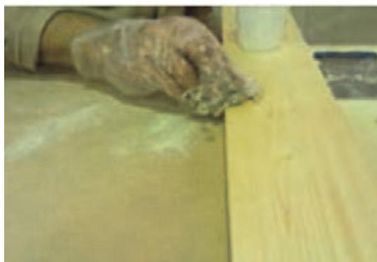
شکل ۶۶- زدن آب قبل از بتنه کاری
