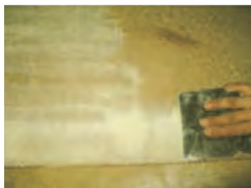
شکل ۵۴- آب زدن به بتونه هم‌رنگی شکل ۵۵- یک تخته آستری خورده شکل ۵۶- استفاده از بتونه رقیق در مرحله اول
