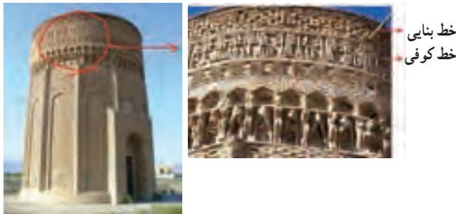
آجر کاری — برج مهماندوست دامغان
