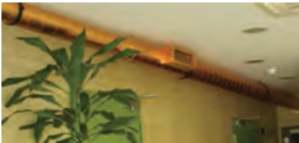
شکل ۳۹- استفاده از فلز مس در دستگیره‌های مکان‌های عمومی، قاب تبلت و کانال کولر از نشر عوامل بیماری‌زا می‌کاهد.
