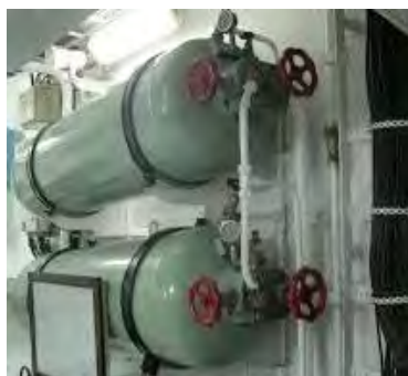
سامانه استارت (هوای فشرده) ۲
