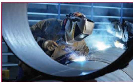
شکل ۵-۱- جوش کاری مخزن فولادی
