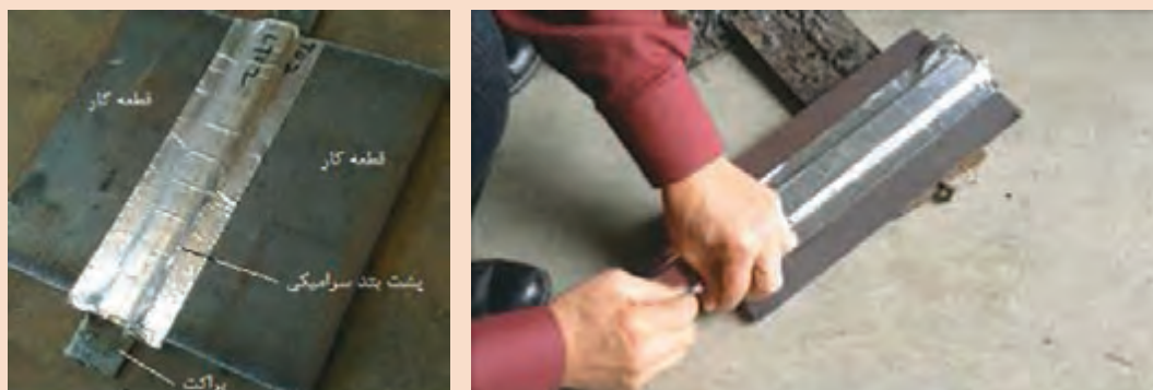
شکل ۱۸- نصب پشت بند سرامیکی
