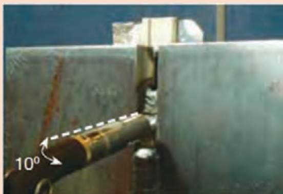
شکل ۲۶- زاویه تورچ و جهت حرکت آن برای انجام پاس سوم
