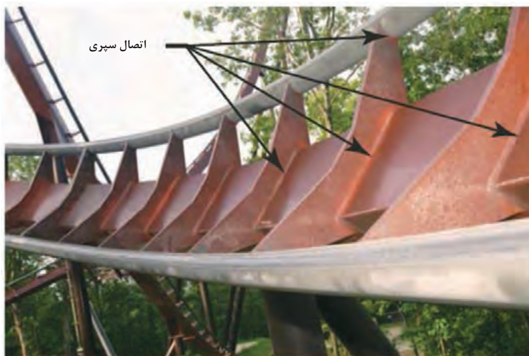
شکل ۱۲- کاربرد اتصال سپری
