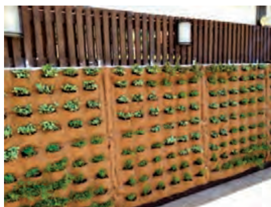
استفاده از الیاف طبیعی در ساخت دیوار سبز
