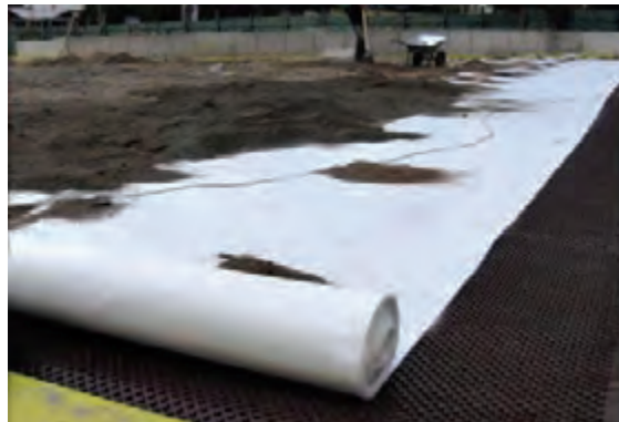
قرارگیری رول ژئوتکستایل در زیر بستر رشد
