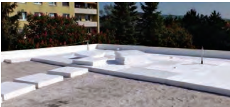
قرارگیری فوم پلی استایرن در روی بام ساختمان
