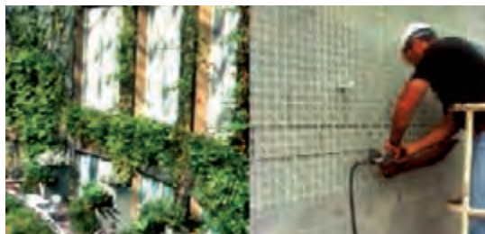
نصب پانل‌ها روی دیوار
