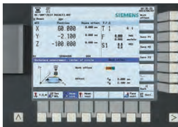
شکل ۱۵- کلیدهای قسمت برنامه‌نویسی سیستم کنترل
