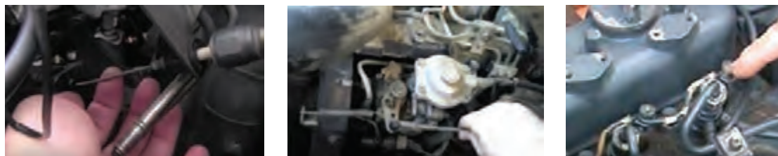
شکل ۸۱- بازدید، بررسی و تنظیم اهرم‌بندی گاز و خاموش کن
