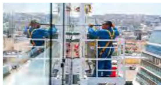
شکل ۱-۱۴ کار کردن در ارتفاع
