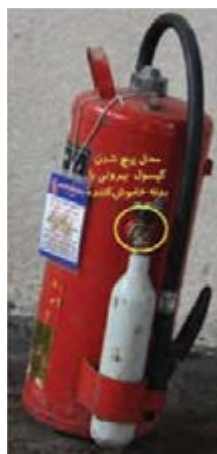
شکل ۹-۳ خاموش کننده پودر و گاز فشنگ خارج
